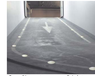
Znaczki zamontowane na podłożu betonowym. Widok w świetle.
