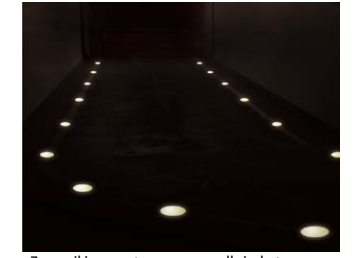
Znaczki zamontowane na podłożu betonowym. Widok po zaniku światła.
