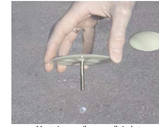
Montaż znacznika na podłożu betonowym z użyciem plastikowych kołków rozporowych.
